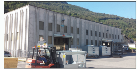
EVAPCO Europe, S.r.l., Sondrio, Italy
